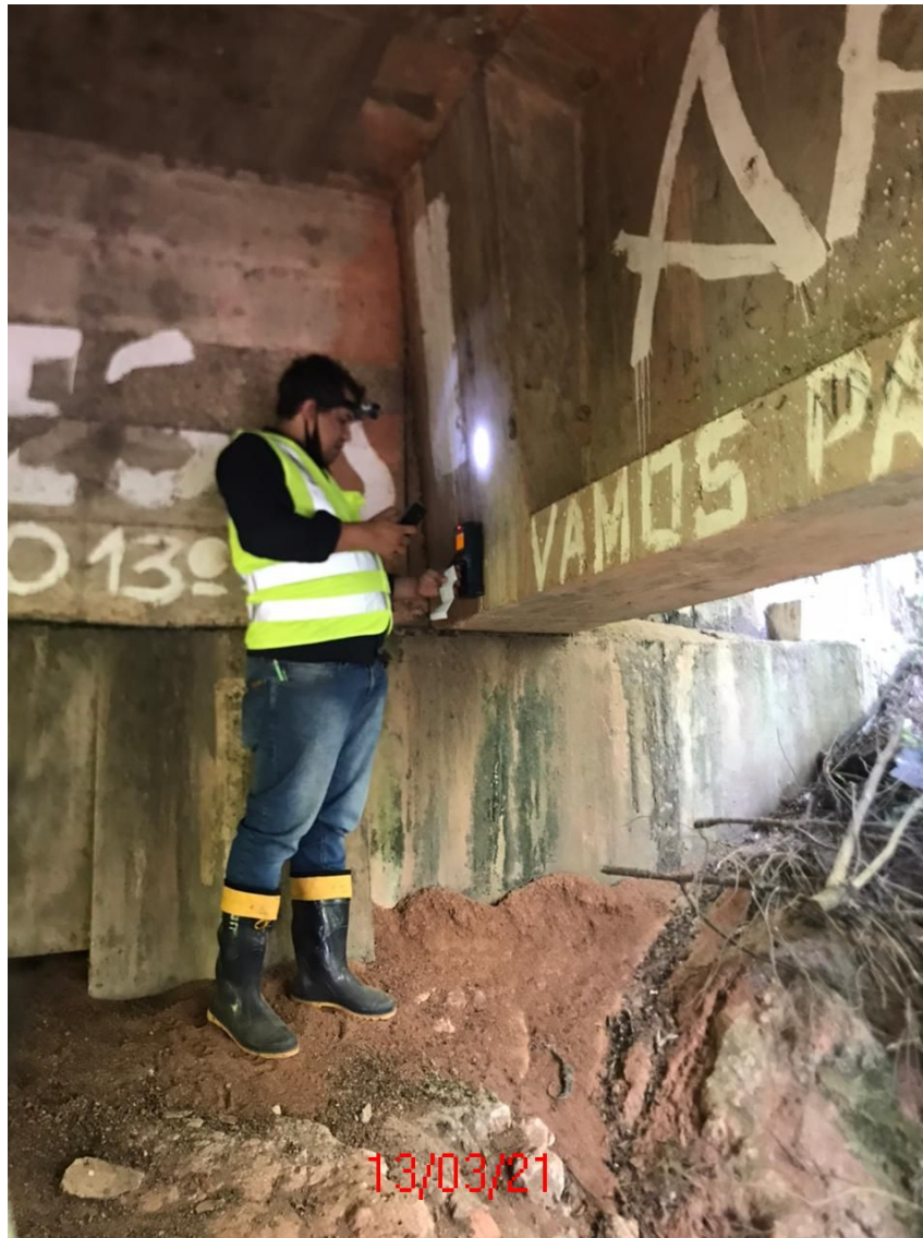
Figura 4 – leitura das armaduras com pacômetro
