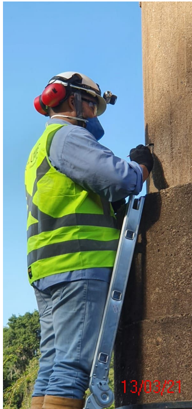
Figura 2 - limpeza dos furos com pincel
