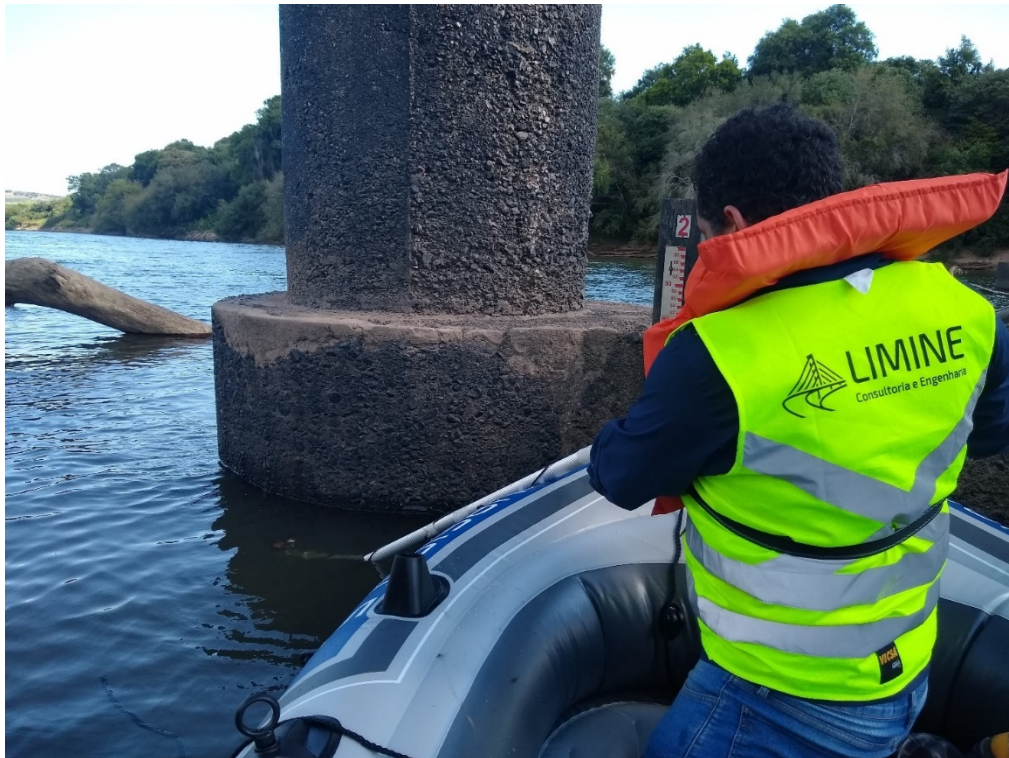
Figura 110 - inspeção visual das fundações
