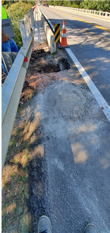
Figura 104 - verificação da laje de transição 1
