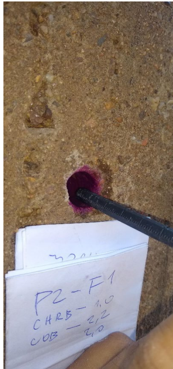
Figura 82 - ensaio da carbonatação P2-F1=1,0cm
