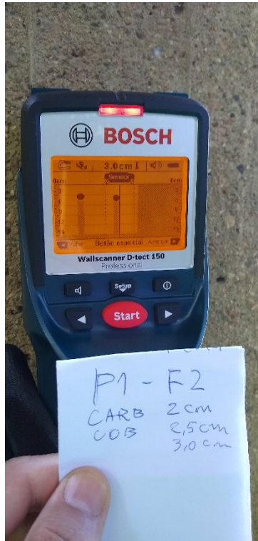
Figura 60 - leitura do cobrimento de concreto P1-F2
