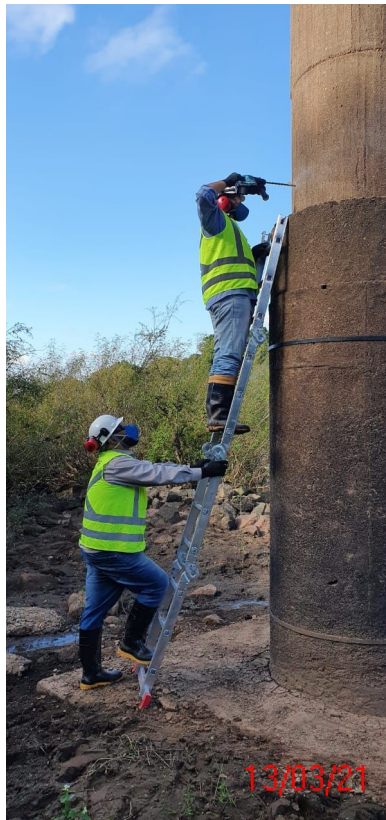
Figura 1 - furação no concreto para ensaios de carbonatação
