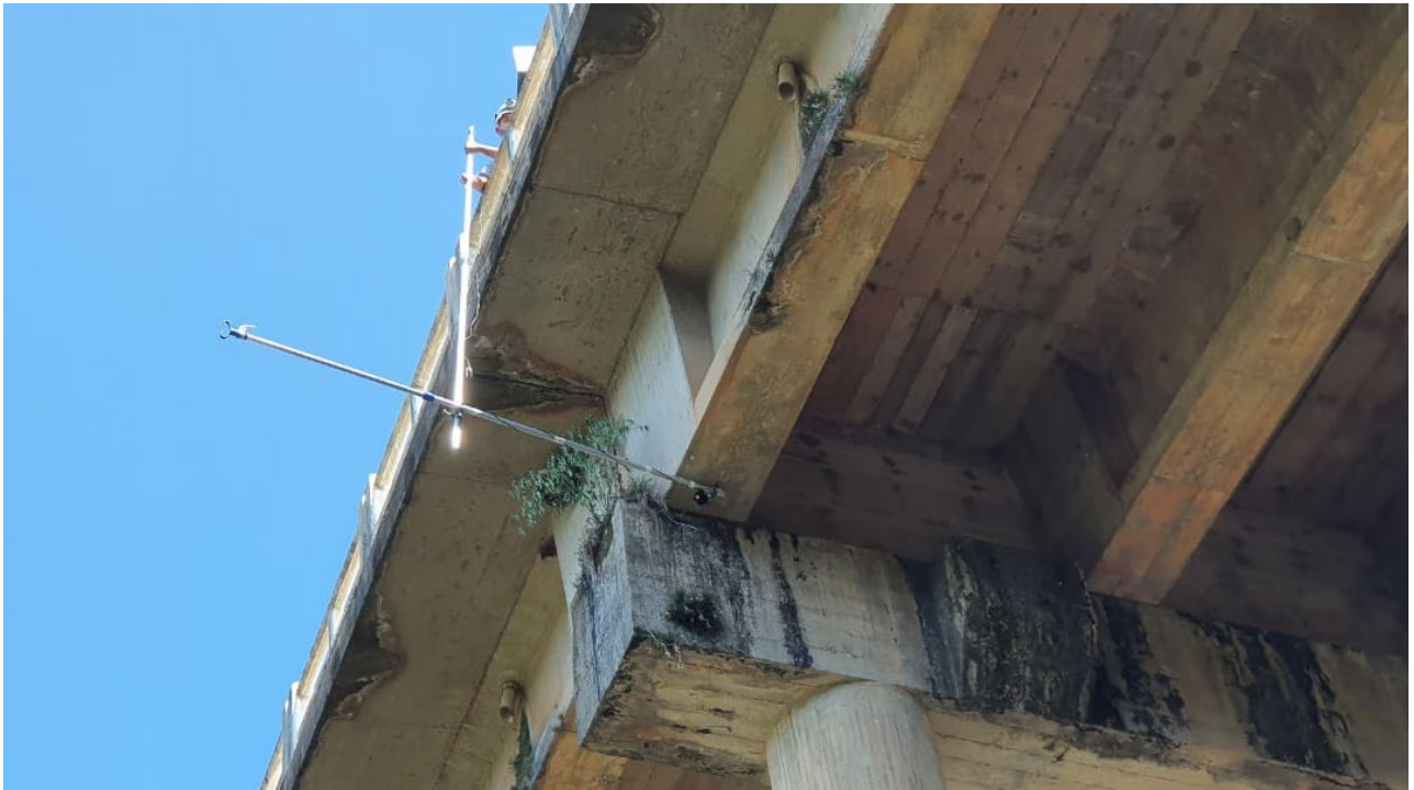
Figura 116 - inspeção dos aparelhos de apoio
