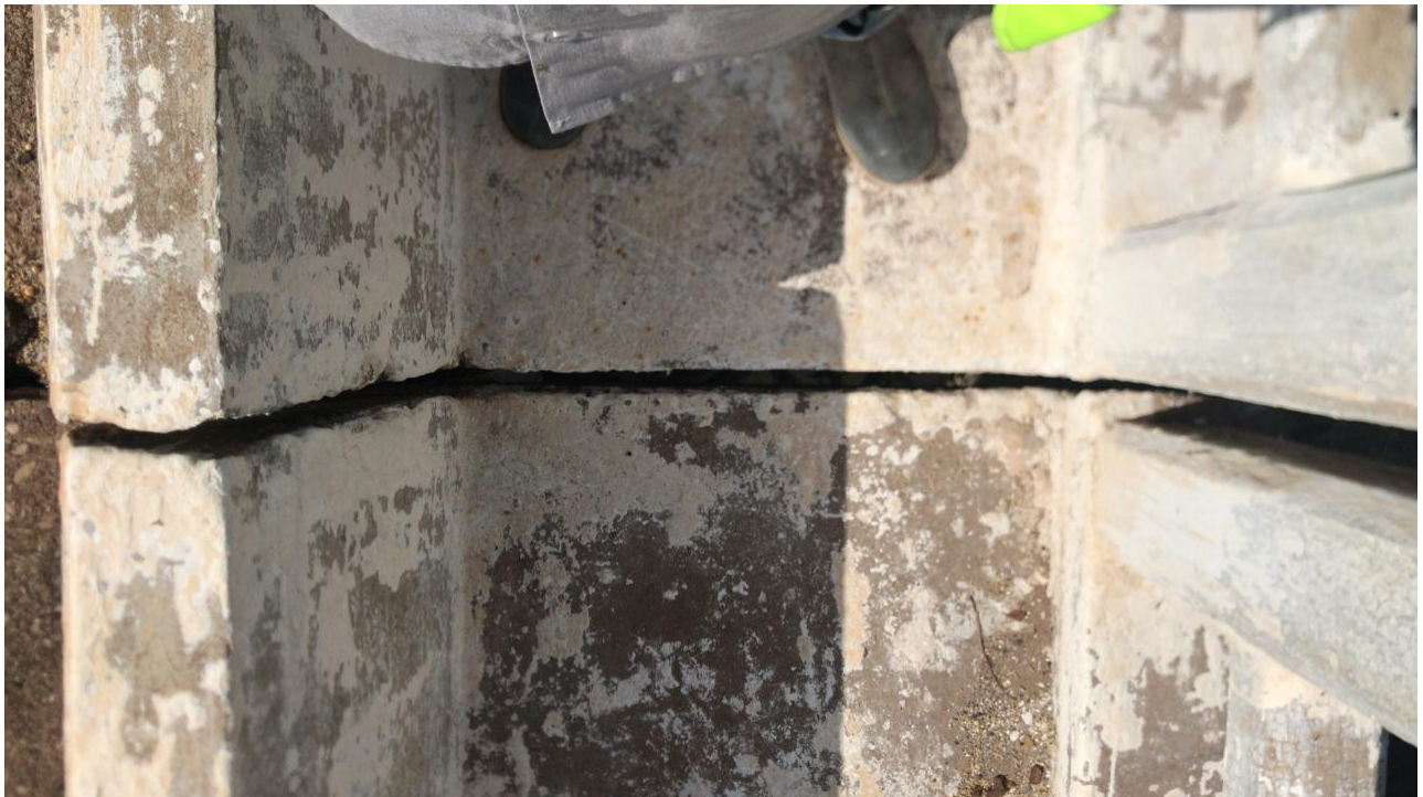
Figura 138 - não identificadas juntas de dilatação no passeio - apoios centrais
