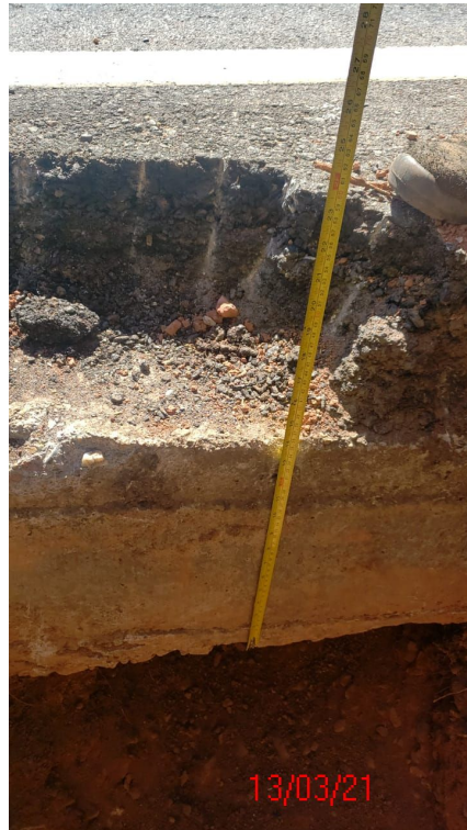
Figura 108 - laje de transição 2 e=35cm
