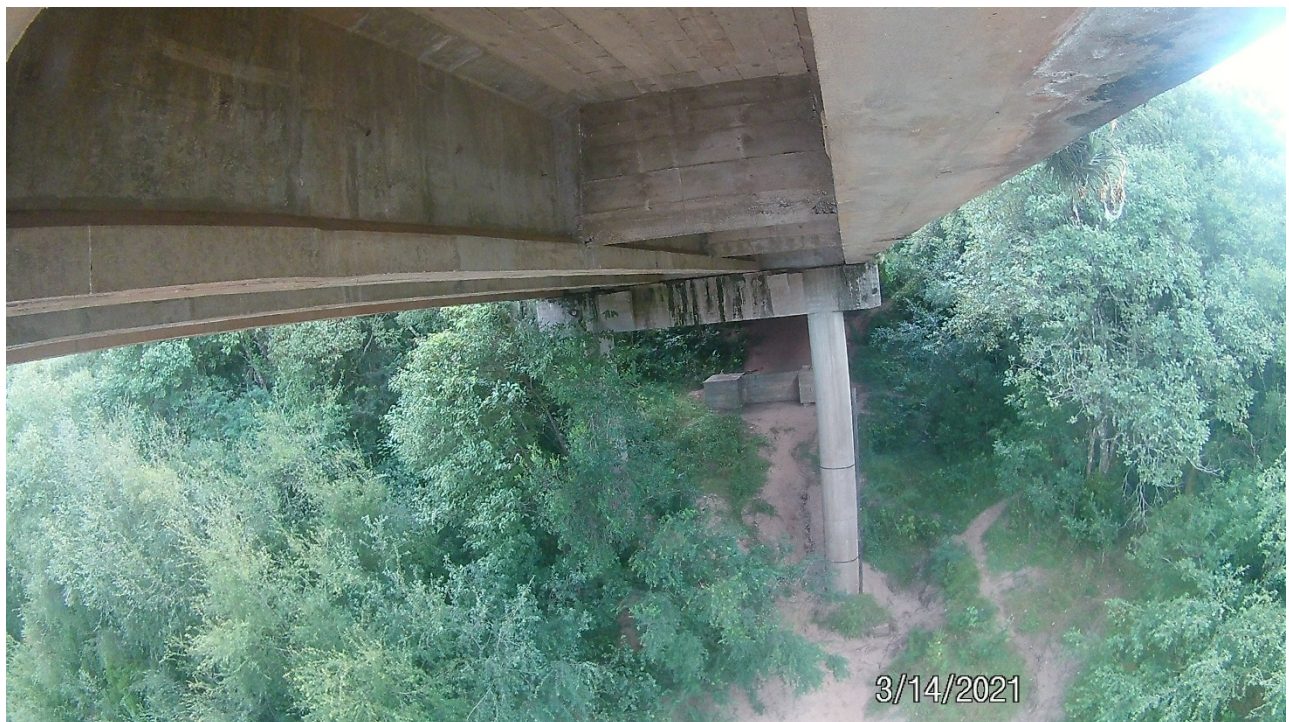
Figura 127 - transversina e laje do vão 2
