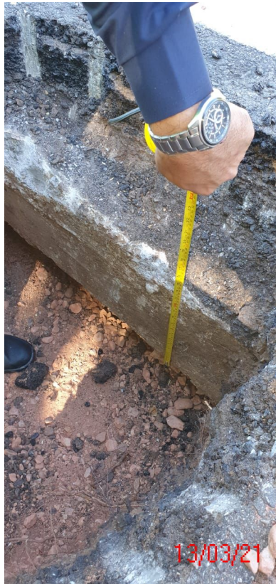
Figura 106 - verificação da laje de transição e=35\text{cm} 1
