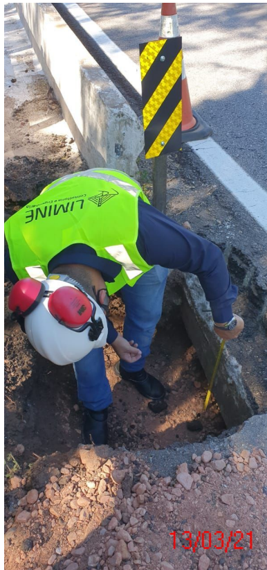
Figura 105 - verificação da laje de transição 1
